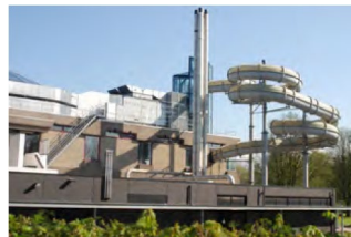
Bijzondere elementen zijn de gebouwen met meer complexe vormen
