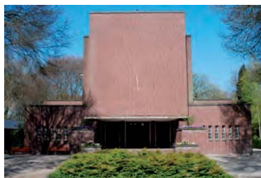
Bebouwing op begraafplaatsen is veelal zorgvuldig gedetailleerd
