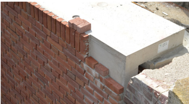
Detail betonconstructie met bekleding van metselwerk.
