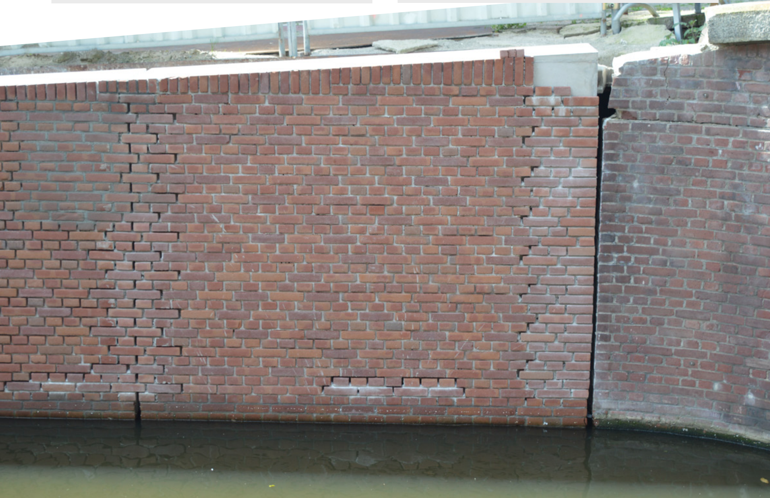
Detail betonconstructie met bekleding van metselwerk.
