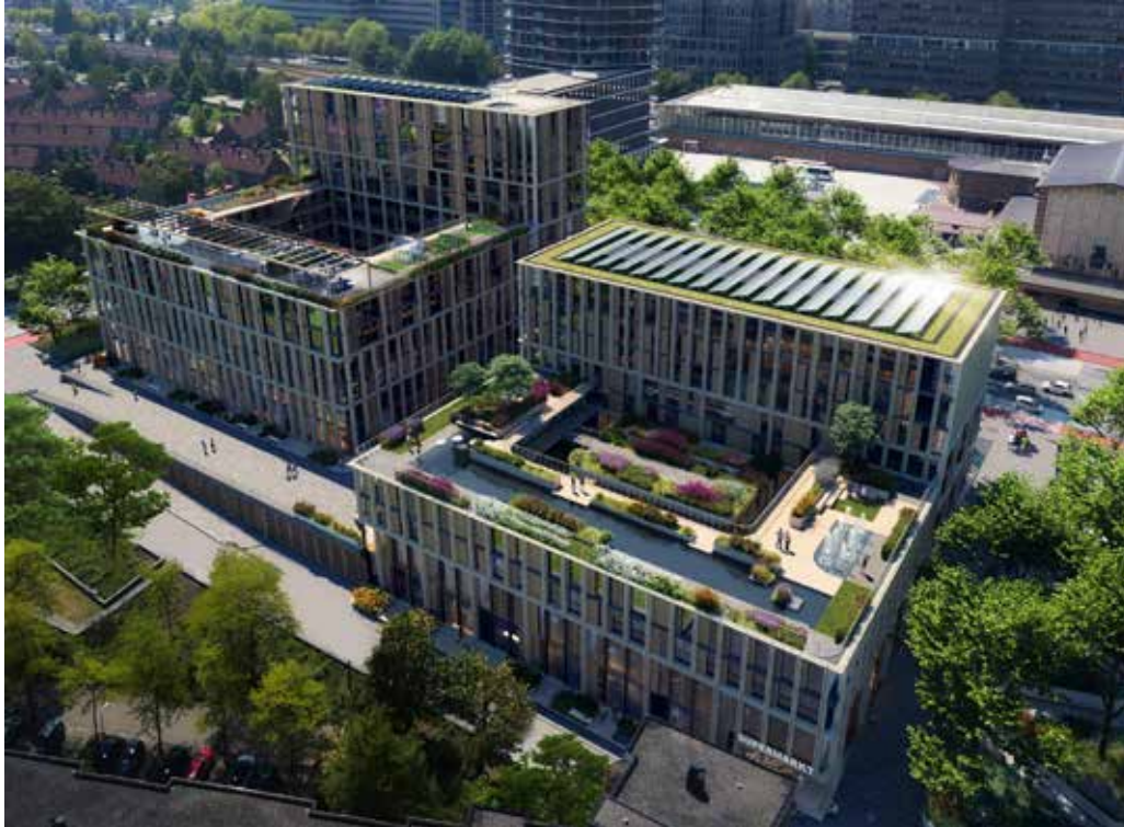
Julianaplein , plan voor twee woonblokken op kavel B en C van het stedenbouwkundig plan Amstelstation en Omgeving uit 2009. (Ontwerp: VenhoevenCS architecture+urbanism)
