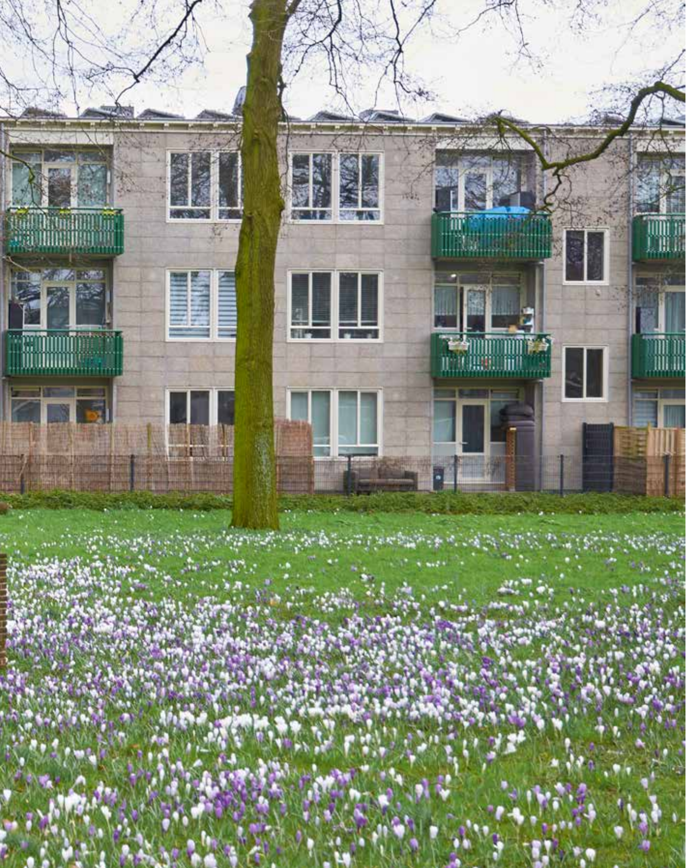
Slotermeer, Johannes Poststraat en Postmahof: hoogwaardige renovatie van zeven van de veertien Airey-blokken in beschermd stadsgezicht 'Van Eesterenmuseum'. Isolatie achter de originele gevelbeplating, isolatieglas en zonnepanelen op de platte daken. (Ontwerp: Hooschuur Architecten)
