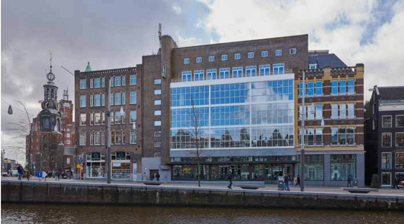
Rokin , voormalige V&D. Het in verschillende fasen tussen 1910 en circa 1930 tot stand gekomen gebouw is getransformeerd tot kantoor, winkels en horeca. Onderdeel van de transformatie waren een hoogwaardige restauratie van gevels en het vrijmaken van de St. Jorissteeg die in de loop der jaren bij het gebouw was getrokken. (Ontwerp: Office Winhov)
